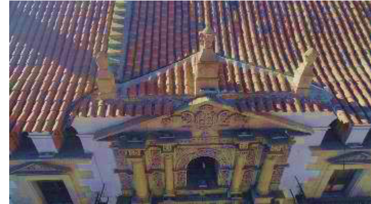
Restauración Cubierta bajante frontal de la CNM, calle Ayacucho
