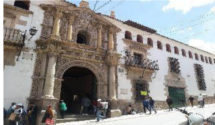
Restauración de la Fachada y portada de Piedra
